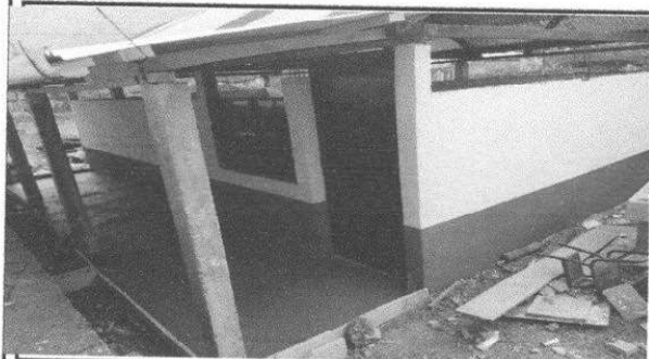
COCINA: Colocación de láminas del techo de corredor, canal de agua, piso, ventana y puerta
