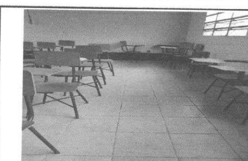
Piso cerámico de las aulas
