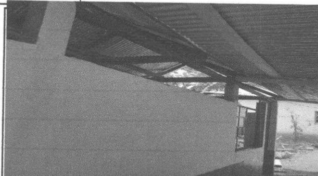
COCINA: Pared repellado y aplicación de pintura de la pared.
